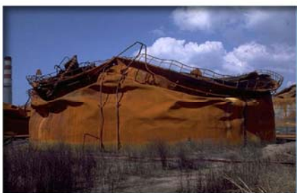
Фиг.4 Състояние на резервоар след пожар, след земетр. в TUPRAS, Izmit, 1999 (PEERC - UC Berkeley)
