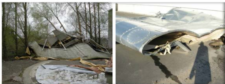
Фиг. 5 Пълен колапс на резервоар в следствие на земетресението в Darfield (2010), (Timbertanks,[40])
