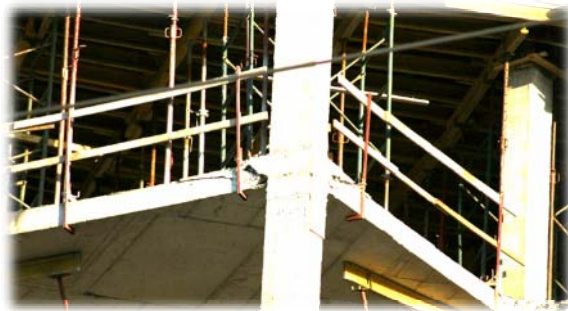
Фиг.13.7А. Продънване по време на изграждане
