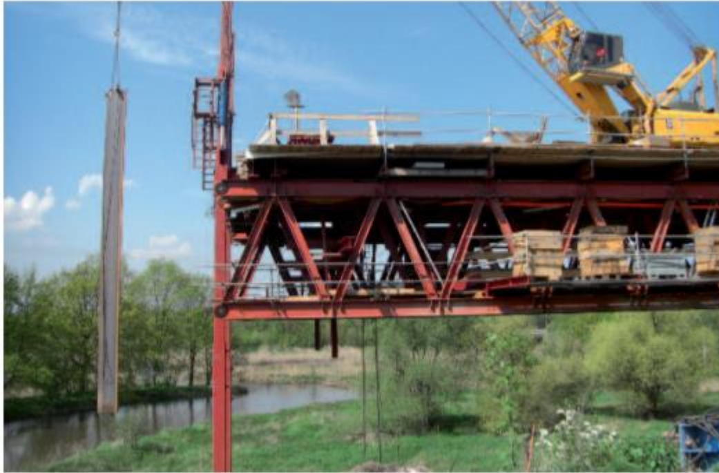
Фиг. 2 Строителство на Виадукт Saale – Elster – Методът “Vorkorbbau”
