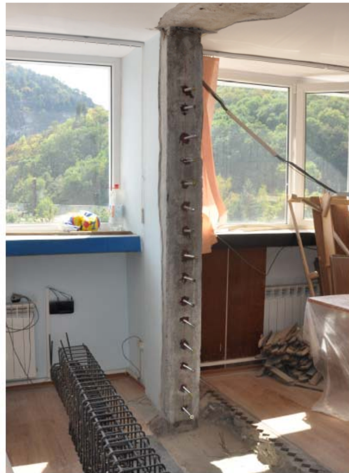
Монтаж на анкерни шпилки
