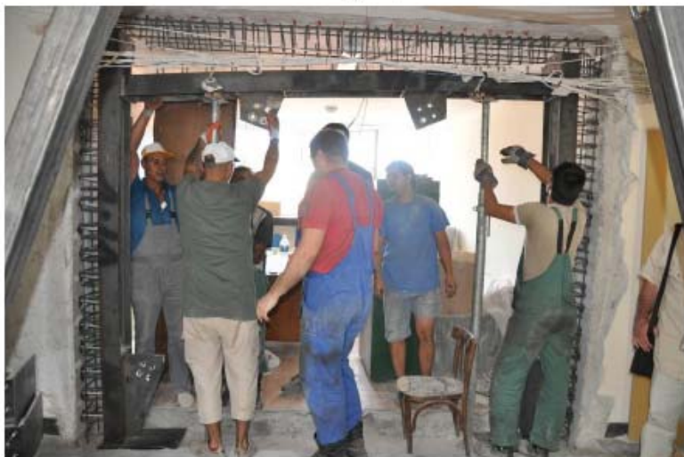
Монтаж на стоманена конструкция
