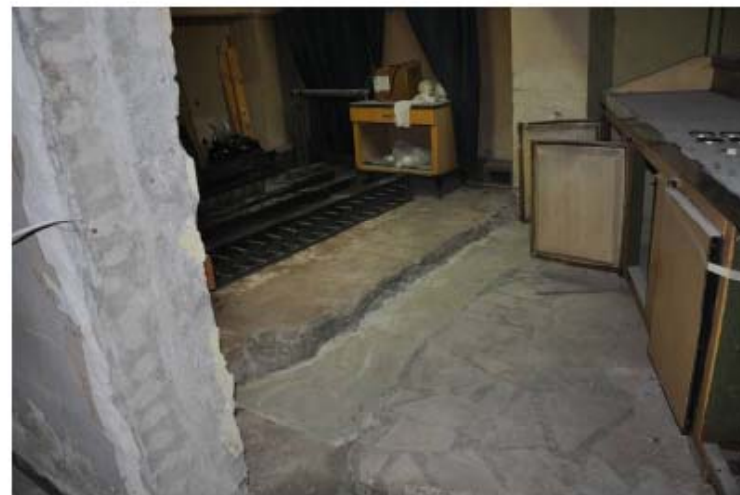
Изпълнение на рандбалки
