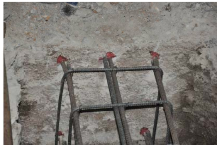
Изпълнение на рандбалки
