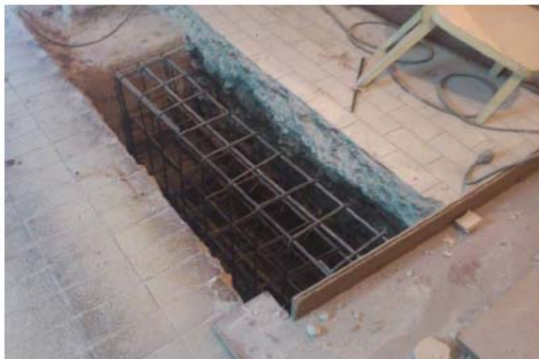
Изпълнение на рандбалки
