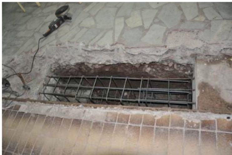
Изпълнение на рандбалки
