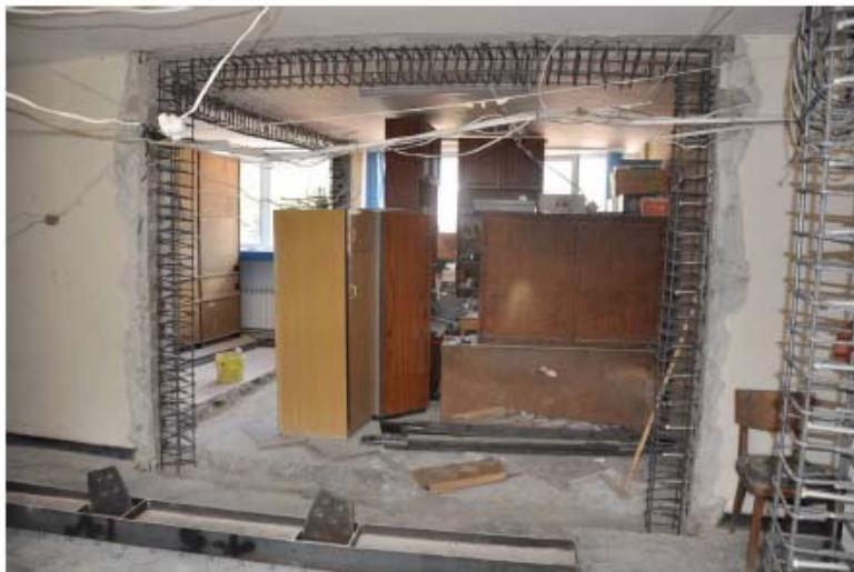
Монтаж на стоманена конструкция
