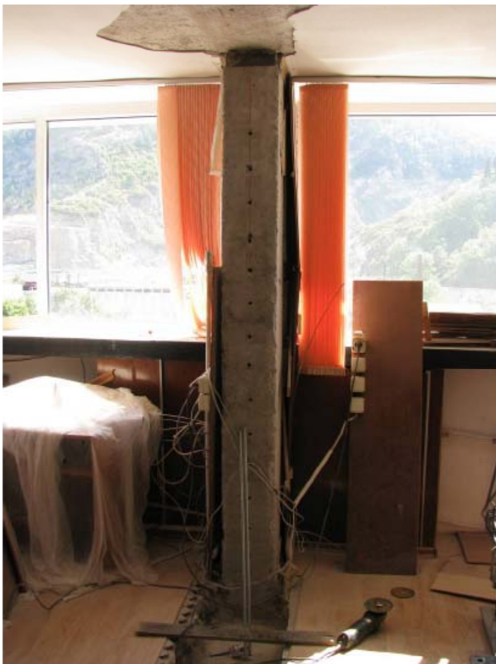
Почистване на повърхностите и изпълнение на отвори
