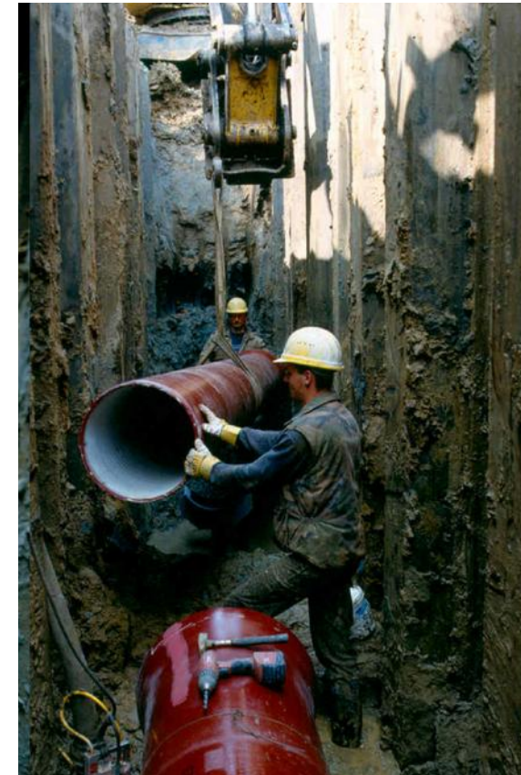
Duktilpfähle 118/7,5 mit Rohrsattel garantieren das Gefälle der Abwasserleitung DN 500 im nichttragfähigen Erdreich
