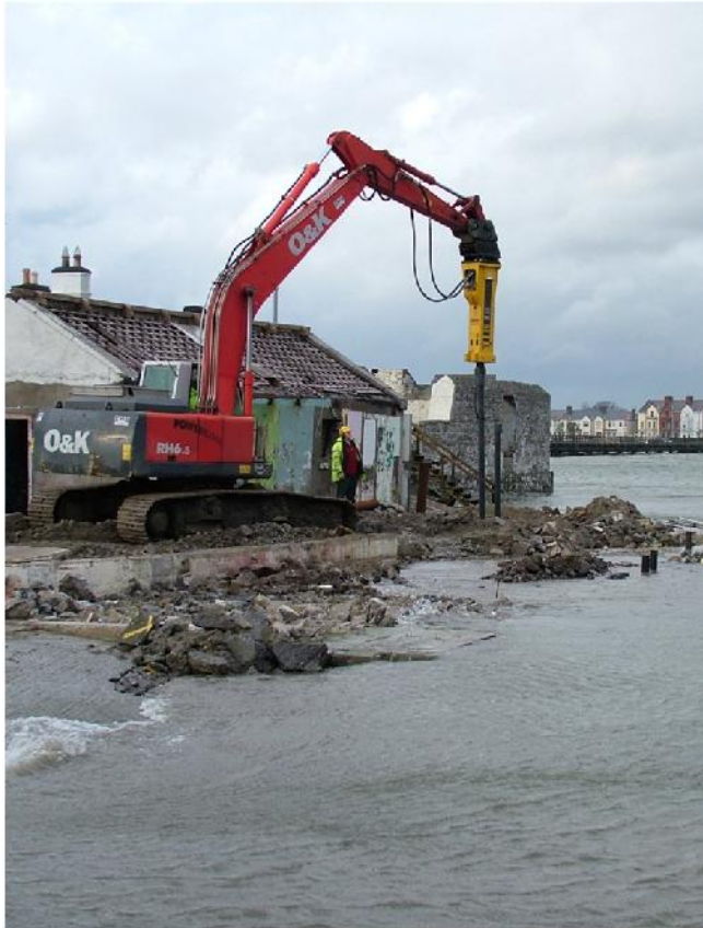
Pfähle 118/9,0 im Salzwasser
