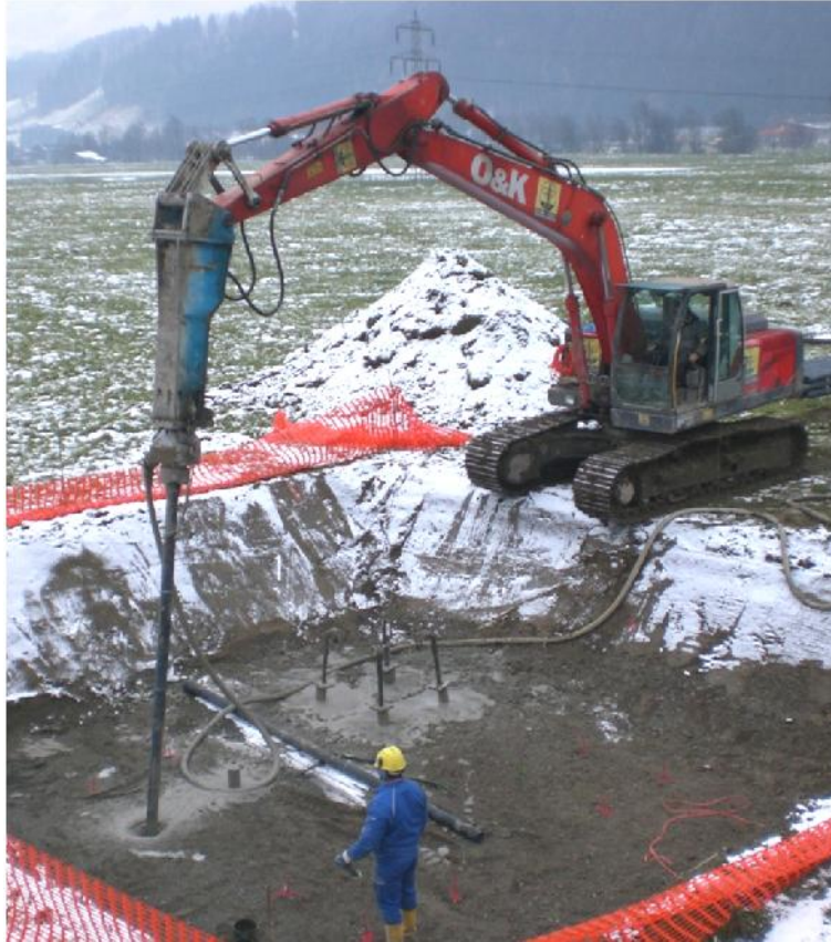
Verpresste Pfähle 170/9,0 und 118/7,5 von 8,0 bis 15,0 m
