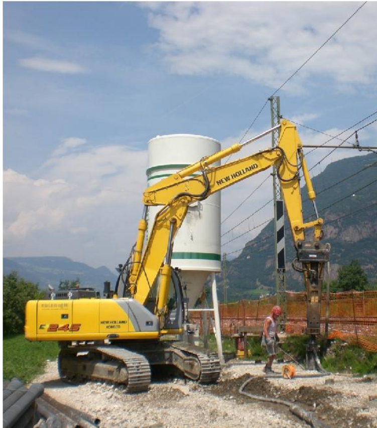
Verpresste Pfähle 118/7,5: 30.000 m in 30 Wochen
