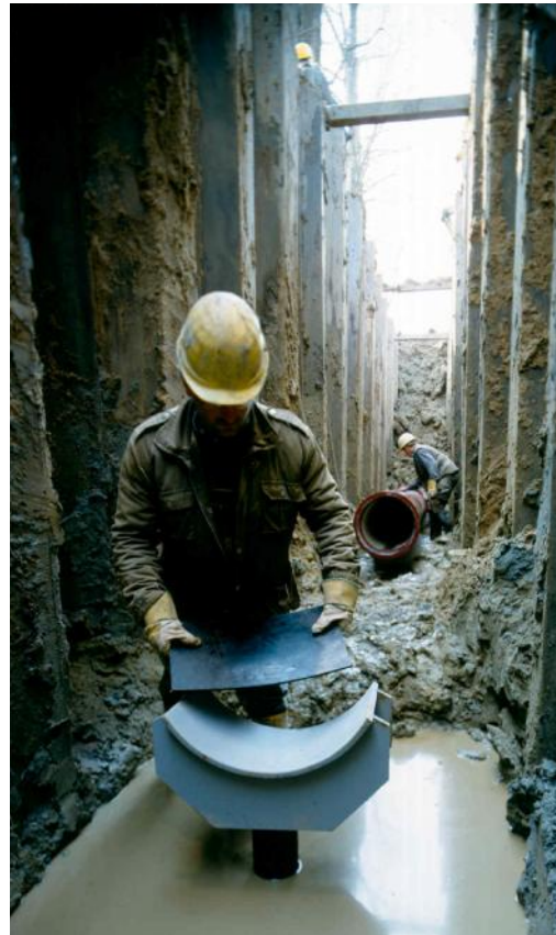
Duktilpfähle 118/7,5 mit Rohrsattel garantieren das Gefälle der Abwasserleitung DN 500 im nichttragfähigen Erdreich
