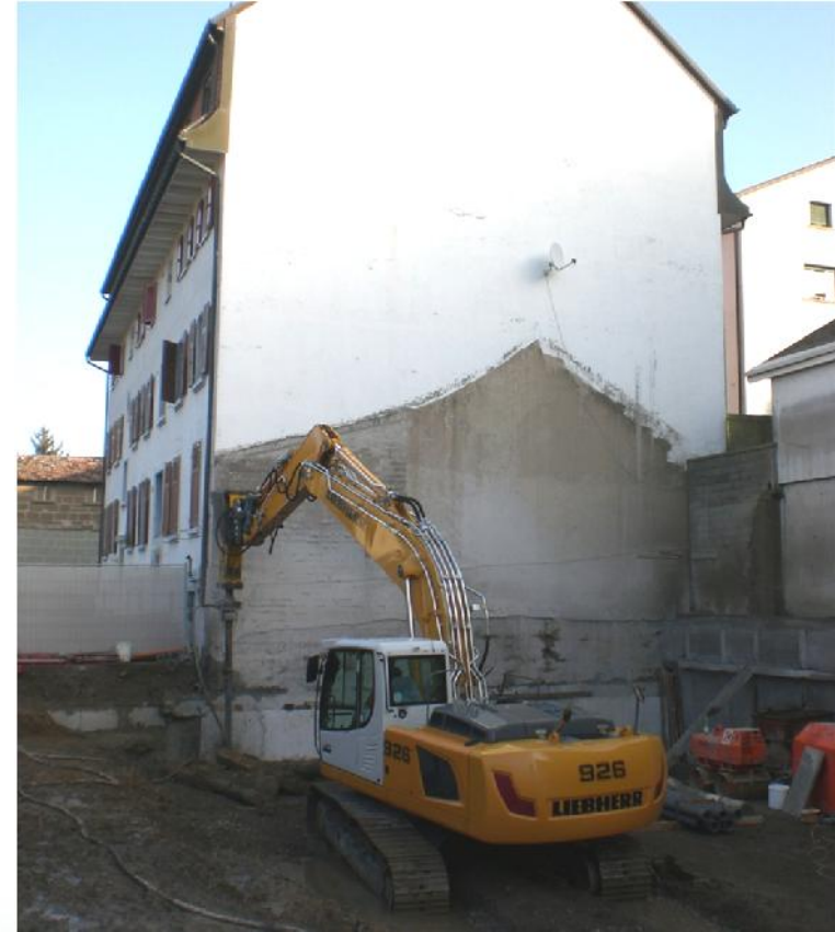
Rammen der Pfähle am bestehenden Gebäude
