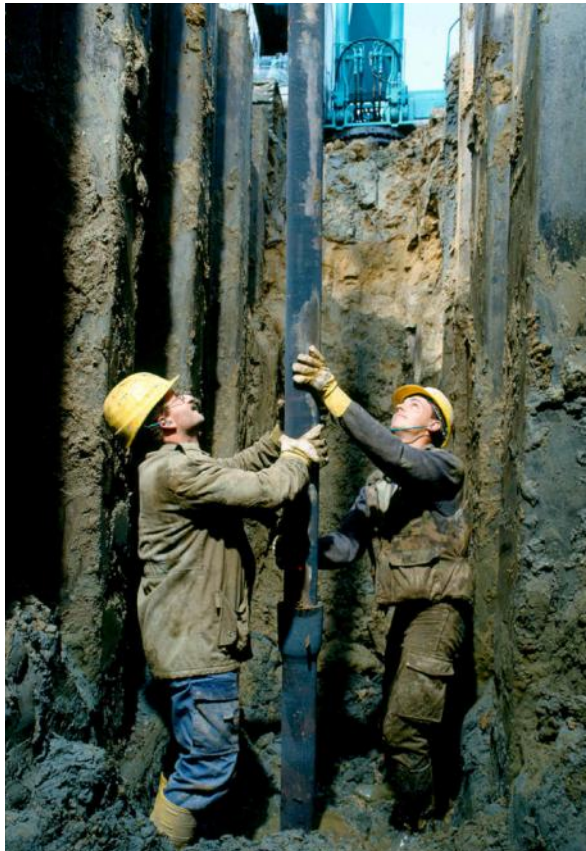
Duktilpfähle 118/7,5 mit Rohrsattel garantieren das Gefälle der Abwasserleitung DN 500 im nichttragfähigen Erdreich
