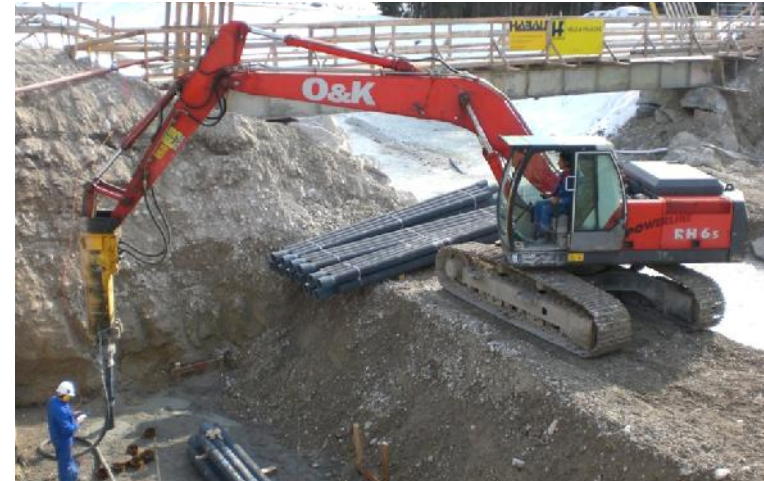
Verpresste Pfähle 170/9,0, Länge 12,5 m
