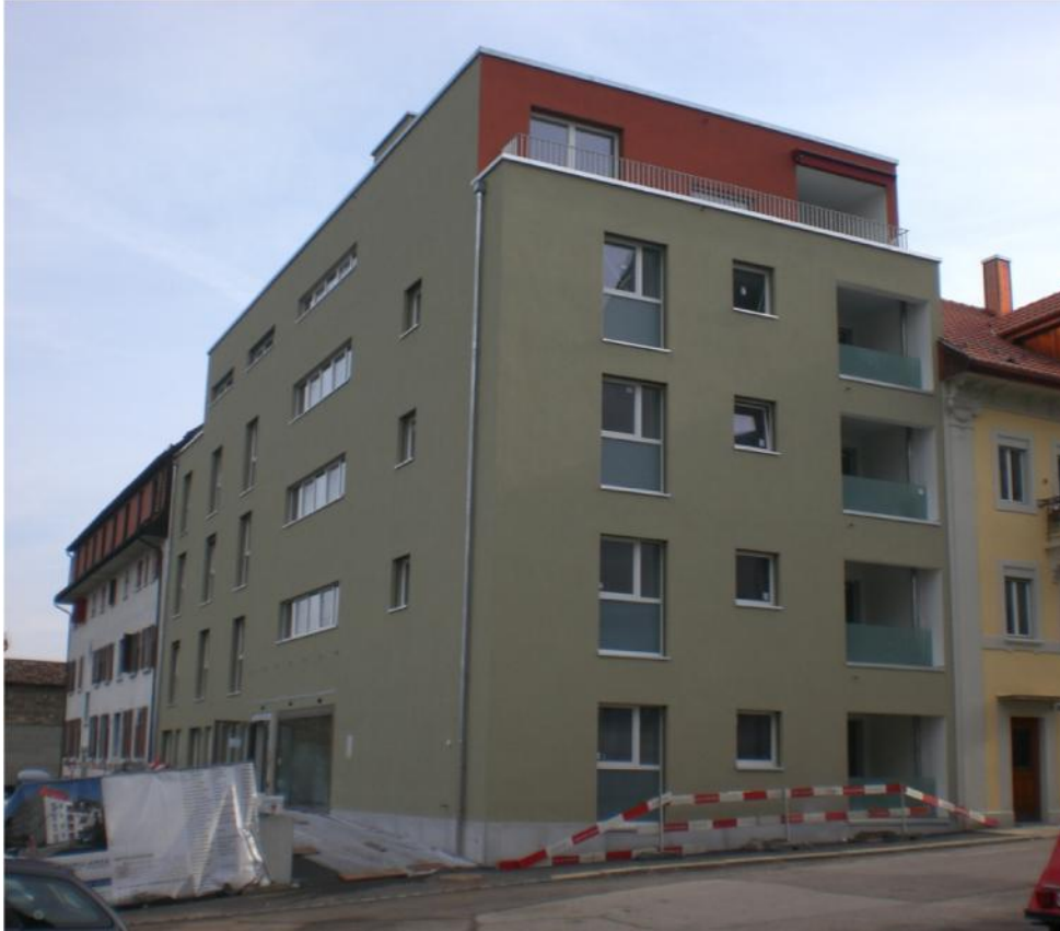
1.200 m verpresste Pfähle 118/7,5 und 118/10,6: Länge 7,0-8,0 m
