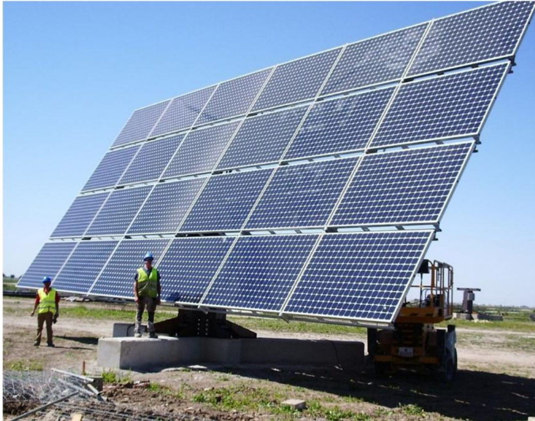
Der Lastabtrag der Solarmodule erfolgt durch je 3 Pfähle
