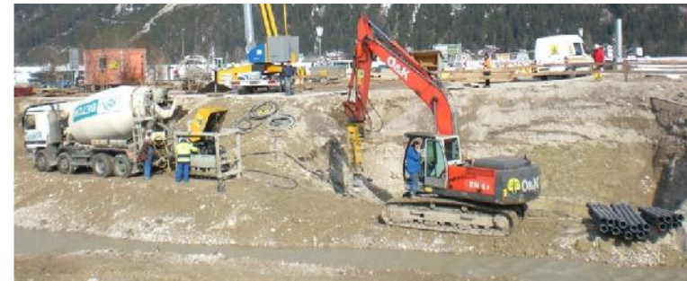
2 Arbeitstage incl Baustelle einrichten und räumen
