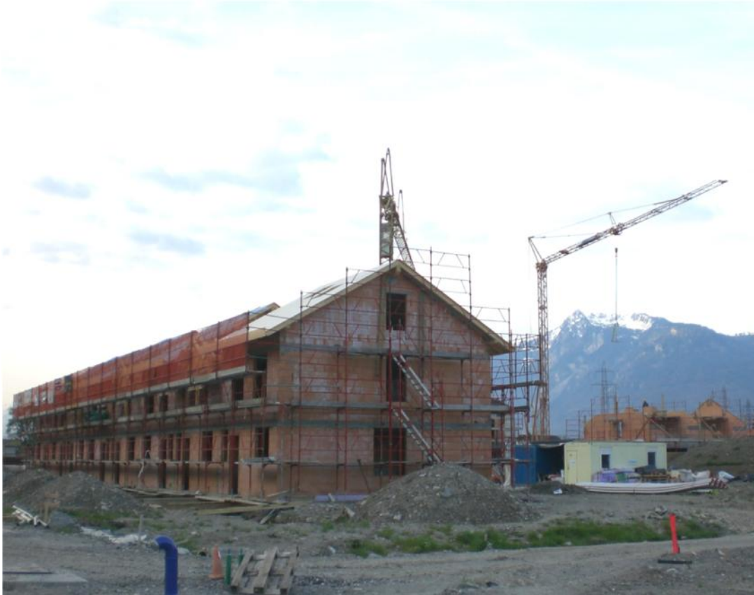
2.700 m verpresste Pfähle 118/7,5 im Grundwasser: Länge 10,0-15,0 m
