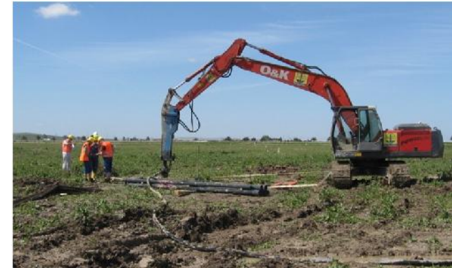
Verpresste Pfähle 118/7,5 von 15,0 bis 25,0 m
