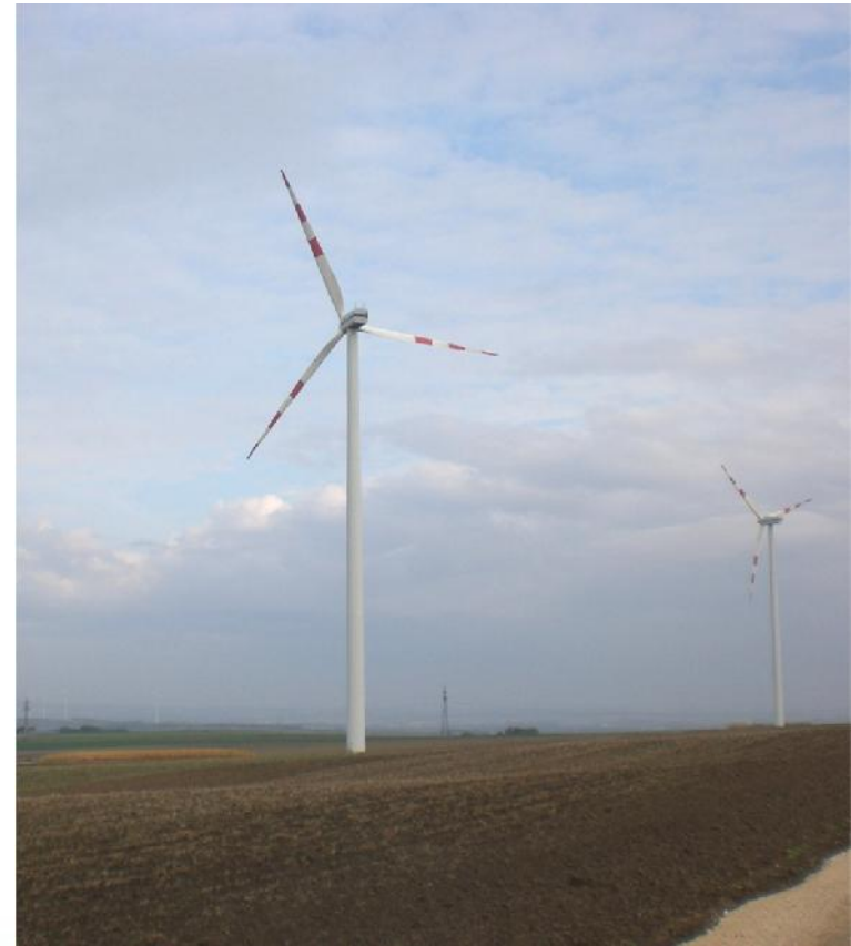
32 verpresste Pfähle 170/10,6 für Windturbine Vestas V90
