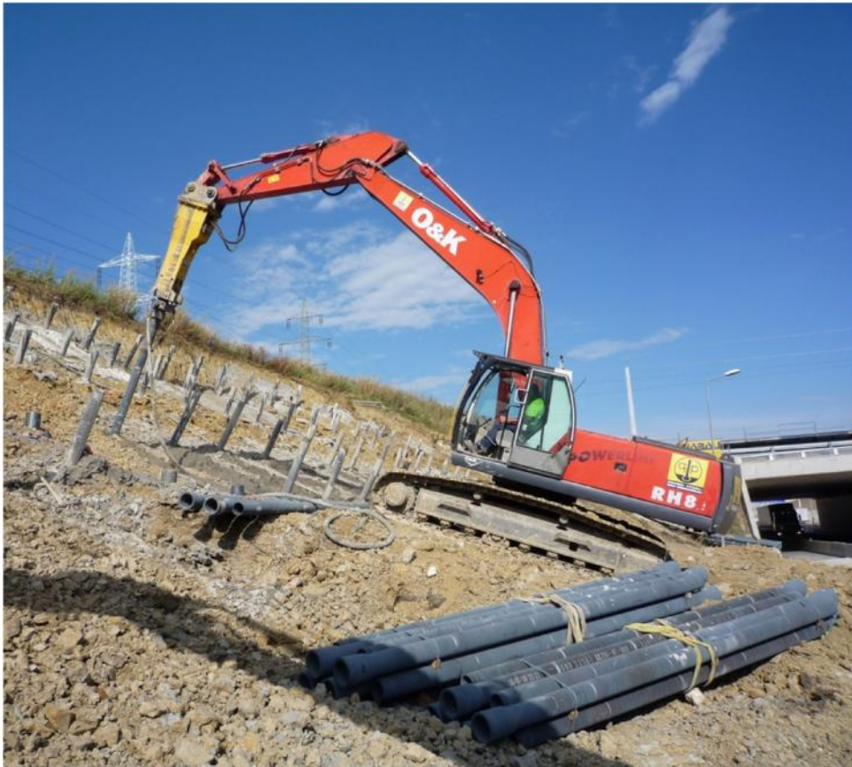
2.500 m verpresste Pfähle 170/10,6 mittlere Länge 9,0 bis 10,0 m
