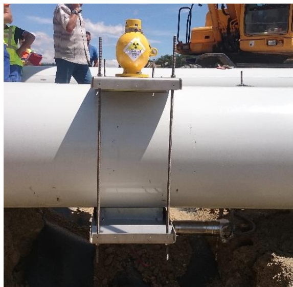
Фиг. 3 Монтаж на плътномера
