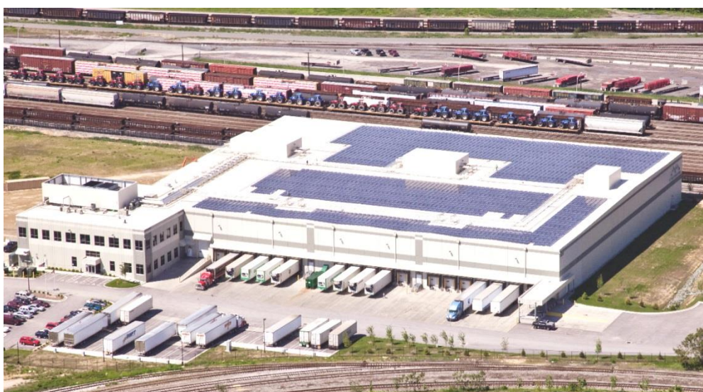
Фиг. 3 Фотоволтаична система на покрива на пристанищен хладилник в Балтимор [8]
